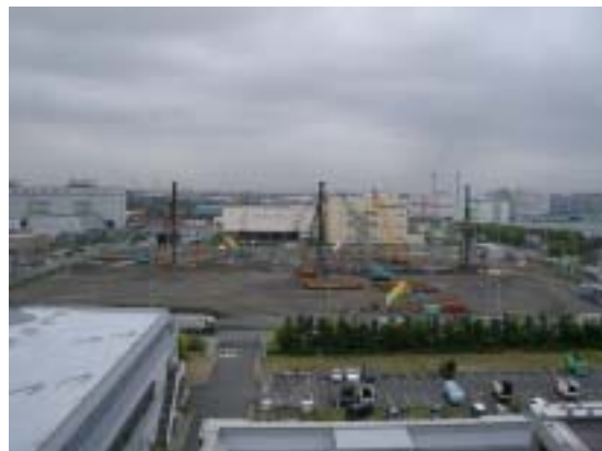
ビーナスプラザ北側での建設工事
