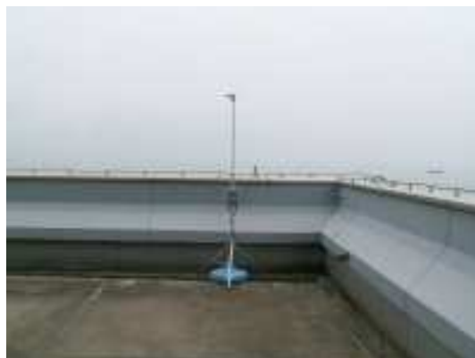
航空機接近検知識別センサー
