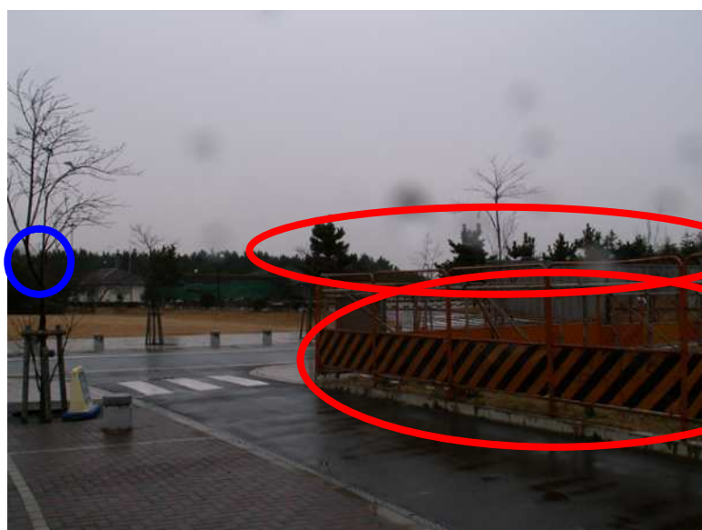
工事現場(赤丸の範囲：手前および奥) 測定用マイクロホン位置は青丸の部分
