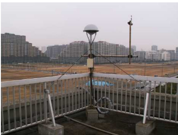
右：航空機接近検知識別センサー 左：航空機最接近検知識別センサー 奥の敷地は工事現場で重機等が稼働
