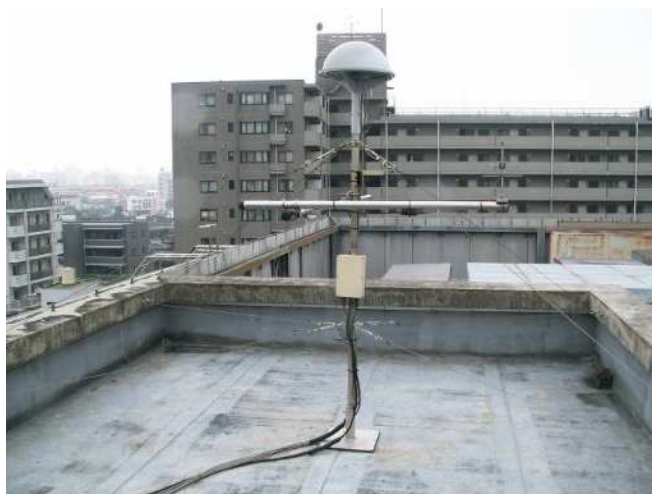
右：航空機接近検知識別センサー 左：航空機最接近検知識別センサー
