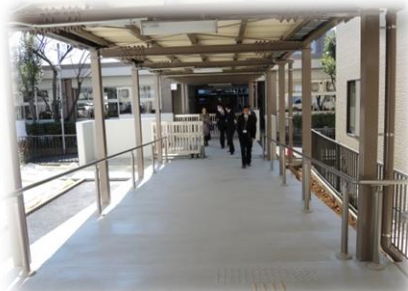
小学校と中学校をつなぐ渡り廊下
