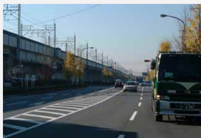
▲JR京葉線の高架橋
