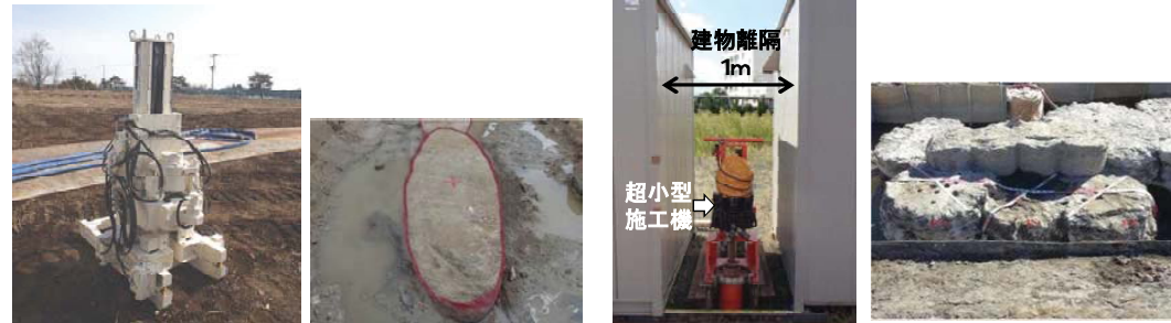
写真-2.1 小型高圧噴射攪拌工法(円・楕円形) 写真-2.2 超小型高圧噴射攪拌工法(円形)
