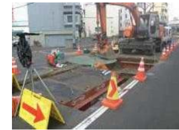
道路覆工板の設置イメージ
