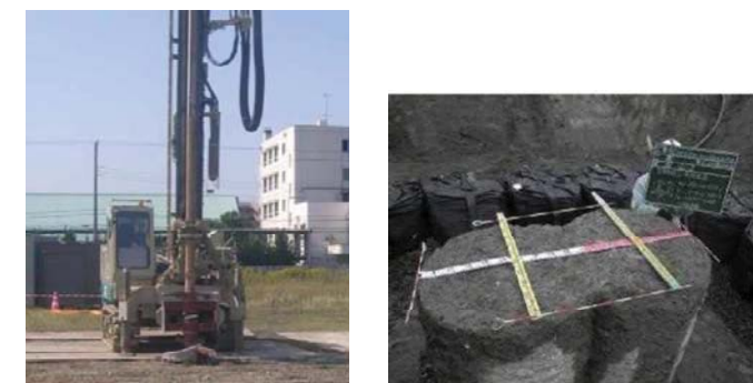
図-2.14 高圧噴射攪拌工法の施工手順 (宅地部を標準)
