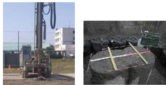
写真-2.3 機械攪拌工法 (円形)
