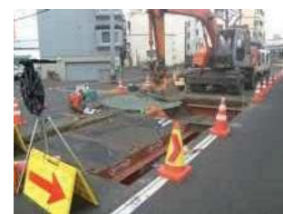
道路覆工板の設置イメージ
