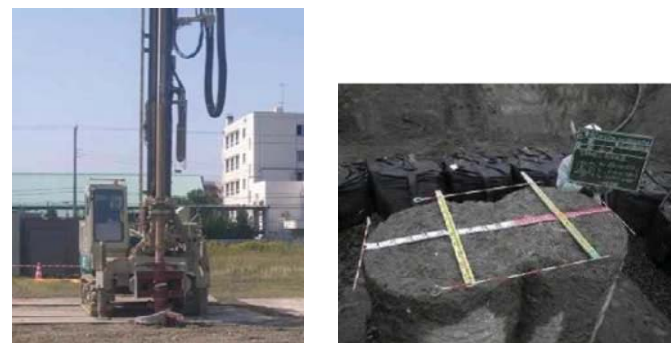
写真-2.3 機械攪拌工法 (円形)
