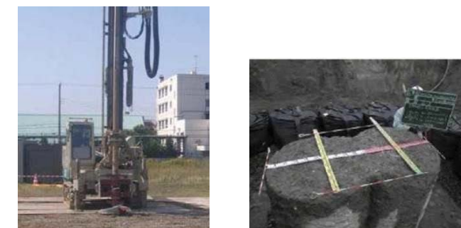
写真-2.3 機械攪拌工法 (円形)
