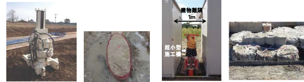
写真-2.1 小型高圧噴射攪拌工法(円・楕円形)
