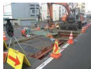
道路覆工板の設置イメージ
