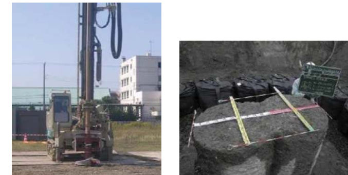
写真-2.1 機械攪拌工法 (円形)
