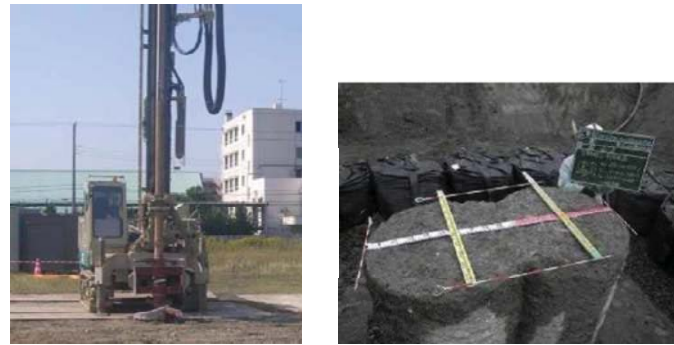
写真-2.3 機械攪拌工法 (円形)
