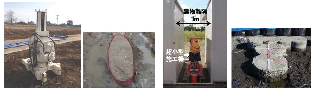
写真-2.2 小型高圧噴射攪拌工法 (円・楕円形) 写真-2.3 超小型高圧噴射攪拌工法 (円形)
