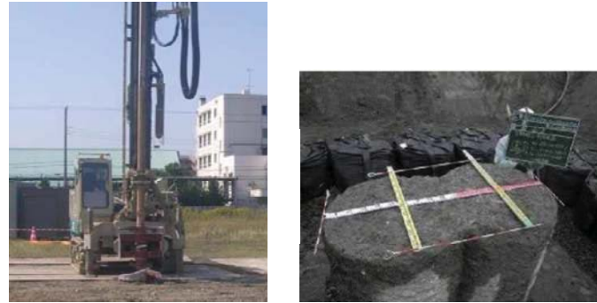
写真-2.1 機械攪拌工法 (円形)
