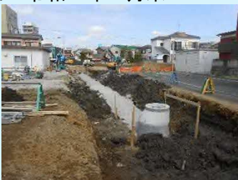
■下水道工事の様子
