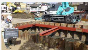
■防火水槽設置の様子
