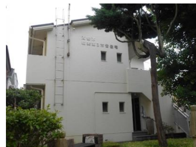
猫実第3市営住宅
