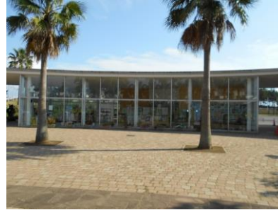
総合公園管理棟
