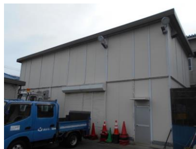
北栄水防倉庫
