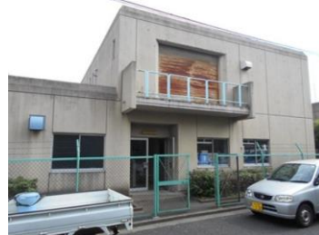
舞浜ポンプ場
