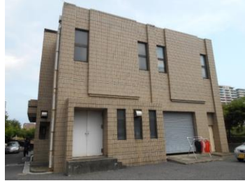
高洲ポンプ場
