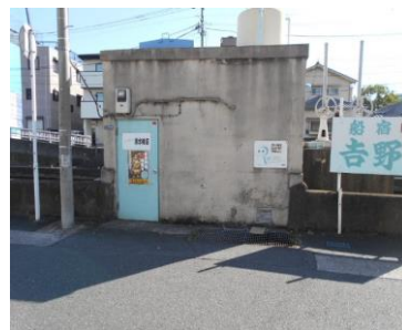
本沢前排水機場
