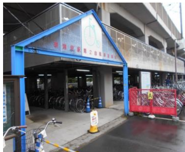
新浦安駅第2自転車駐車場
