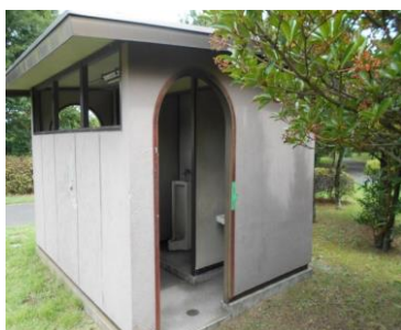
高洲太陽の丘公園トイレ B
