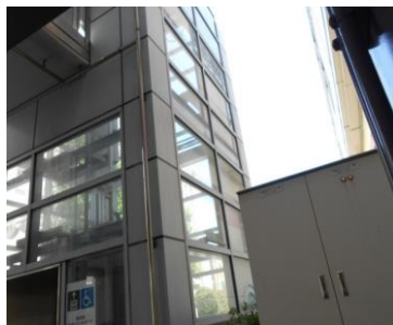
新浦安駅北側エレベーター棟
