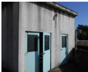
山城屋前排水機場
