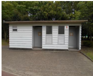
高洲中央公園トイレ
