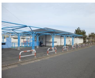
東野プール管理棟
