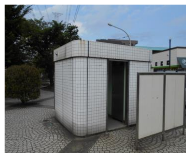
しおかぜ緑道公衆トイレ (堀江1丁目)
