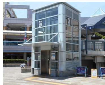
新浦安駅前広場エレベーター棟
