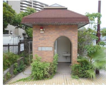
高洲地区境川沿い緑地トイレ
