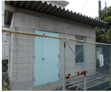
新橋横ポンプ場
