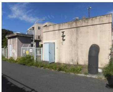
小川丸排水機場
