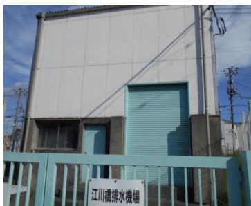
江川橋排水機場
