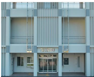
運動公園野球場 (スタンド棟)
