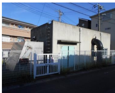
五丁歩排水機場
