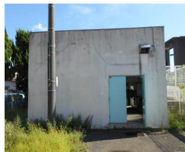
船塚川排水機場
