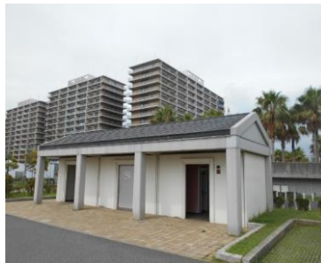
総合公園駐車場側トイレ
