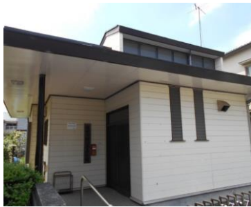
堀江長寿クラブ会館
