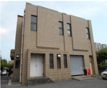
高洲ポンプ場
