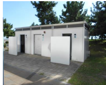
総合公園緑道側トイレ
