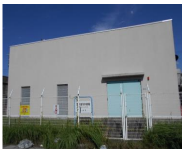
当代島排水機場
