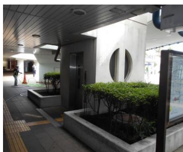
舞浜駅エレベーター棟
