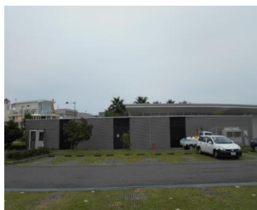
総合公園防災備蓄倉庫
