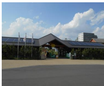
こどもの広場管理棟
