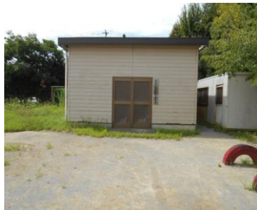
富岡小学校防災備蓄倉庫
