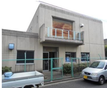
舞浜ポンプ場
