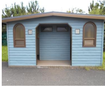
高洲海浜公園トイレB
