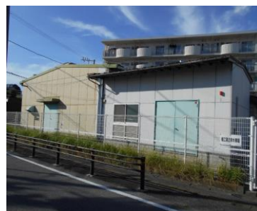
堀江第2排水機場
