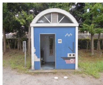
堀江ドックなかよし公園トイレ
