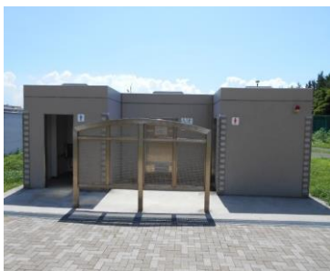
高洲地区西側緑地 (中央区域) トイレ
