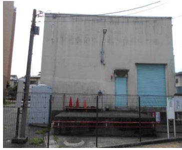
猫実4丁目排水機場
