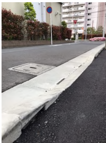
(斜ブロック腹見せ施工)
