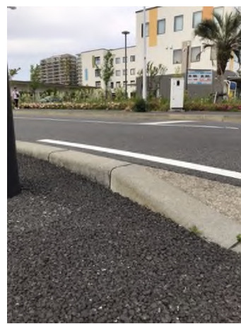
(斜ブロック腹見せ施工)
