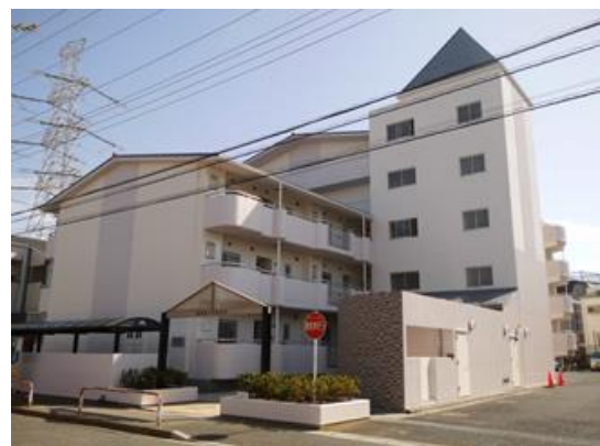
猫実第1市営住宅
