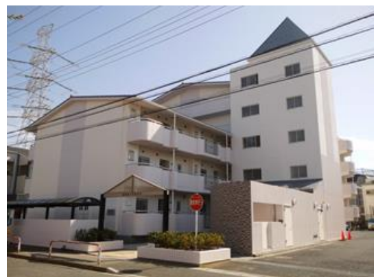
猫実第1市営住宅
