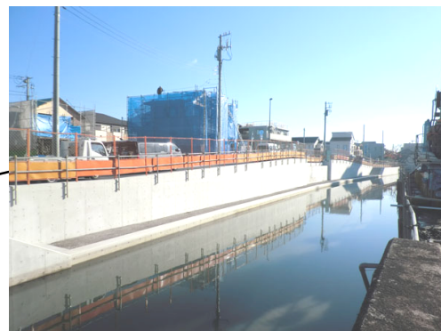
境川護岸（猫実側）
