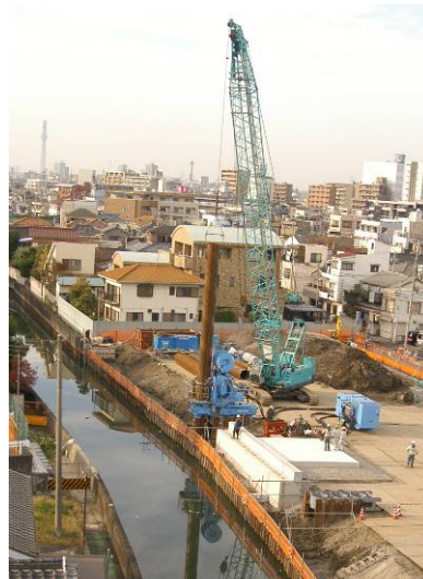
猫実側の橋台設置と護岸工事の様子
