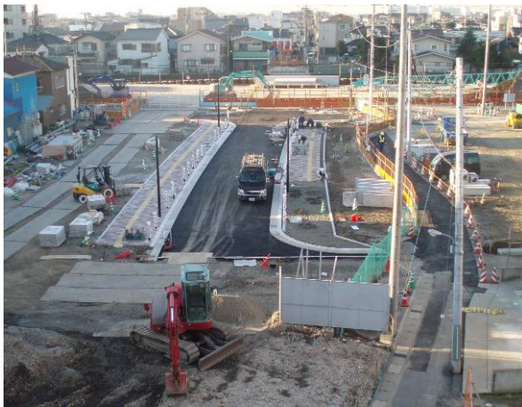
猫実地区の新中通りの工事の様子 (みなと線から境川方面)
