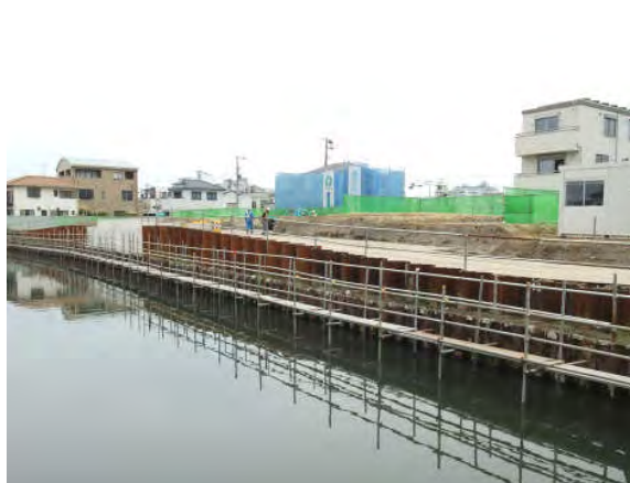
②境川橋台・護岸改修（平成 23 年 6 月撮影）
