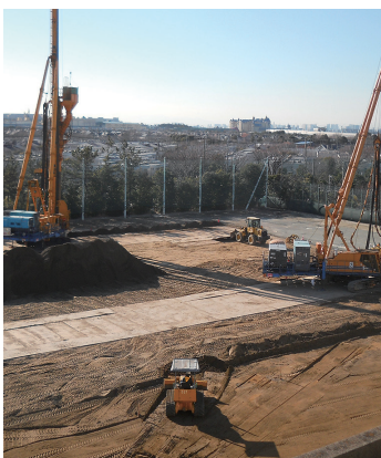
見明川中学校校庭の地盤改良工事の様子
