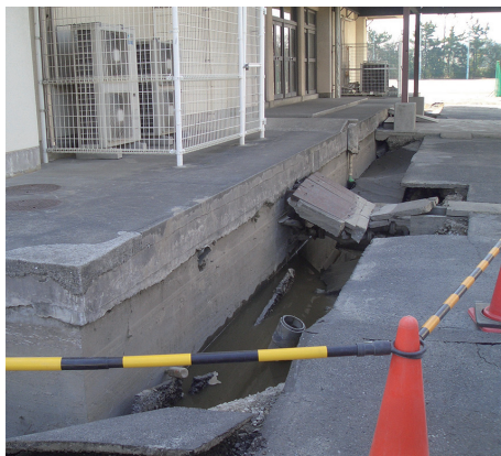
震災直後の見明川中学校 液状化により校舎周りに大きな段差が生じました。
