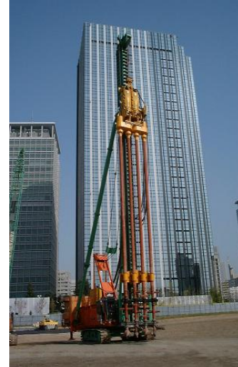
写真-1 大型地盤改良機械
