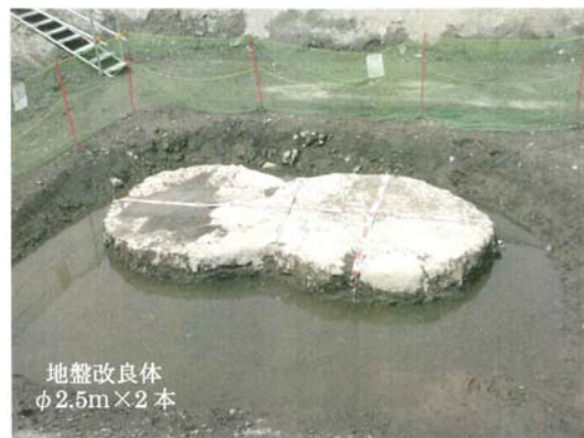
写真-4 狭小地用高圧噴射攪拌工法による改良体
