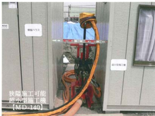
写真-3 狭小地用高圧噴射攪拌工法施工機
