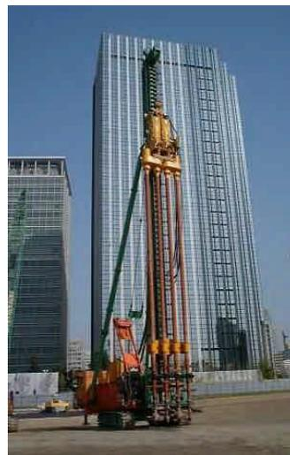
写真-1 大型地盤改良機械
