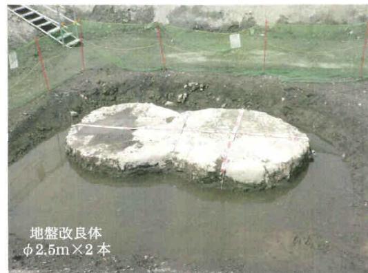
写真-4 狹小地用高圧噴射攪拌工法
