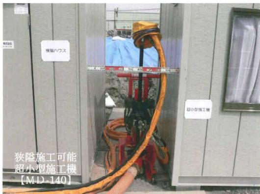
写真-3 狹小地用高圧噴射攪拌
