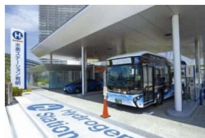
水素ステーション
