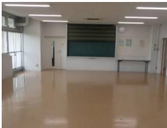
後方から（何も設置していない状態）
