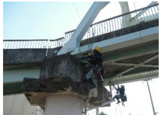
写真－9.1 橋梁点検車、ロープアクセスによる定期点検
