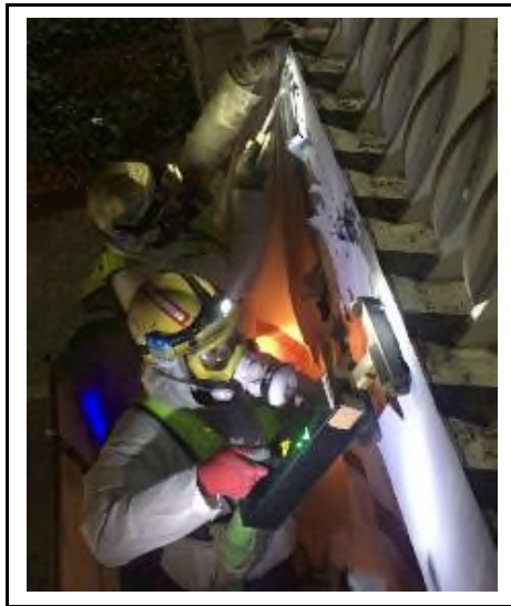
写真－9.3 IH式塗膜剥離工法の施工状況
