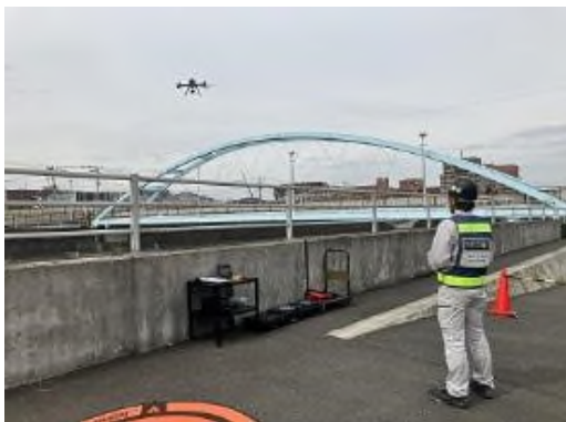
写真－9.2 ドローンを用いた点検状況
