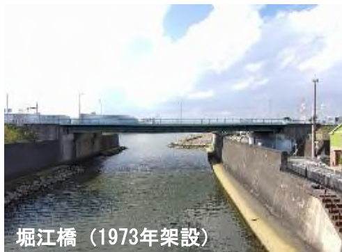
写真－2.1 建設後50年を経過する橋梁
