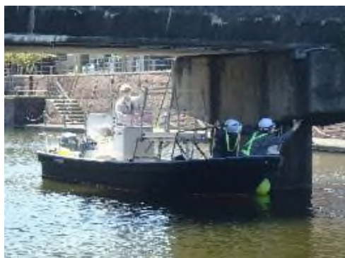
写真－1.1 橋梁定期点検状況
