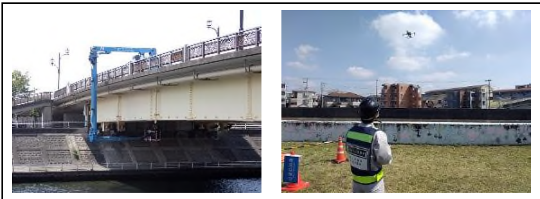
写真－5.1 定期点検状況
