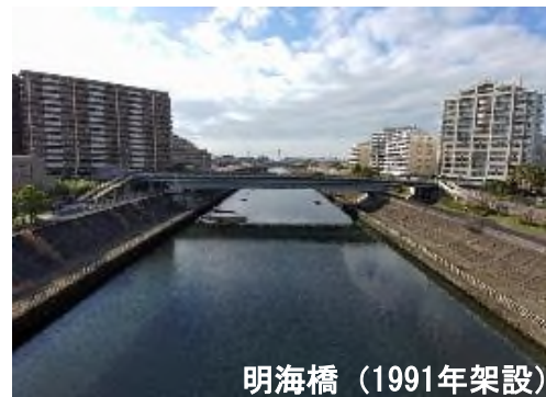
写真－2.2 20年後に50年を経過する橋梁
