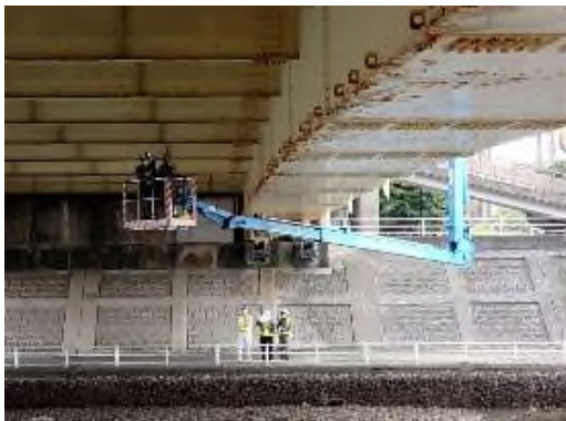
写真－9.1 橋梁点検車、ロープアクセスによる定期点検
