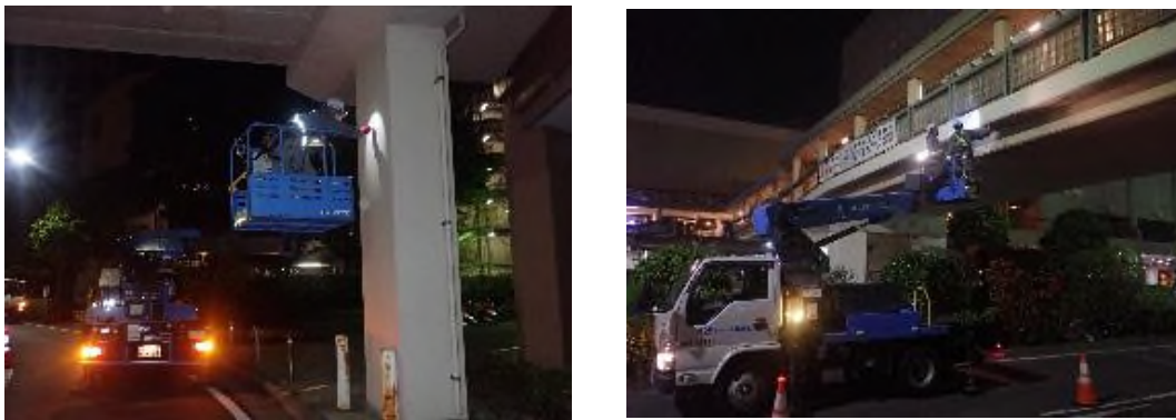
写真－9.1 高所作業車による定期点検
