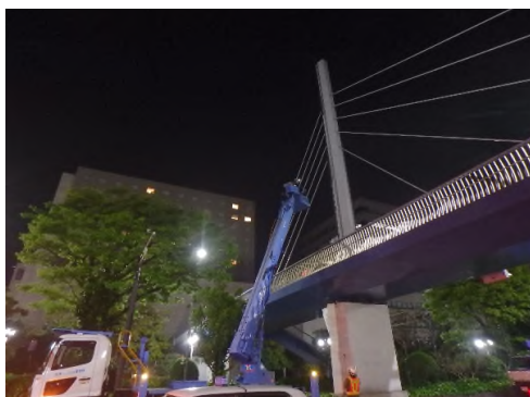
写真－1.1 定期点検状況
