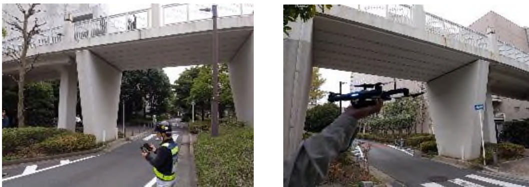
写真－9.2 ドローンを使用した点検状況
