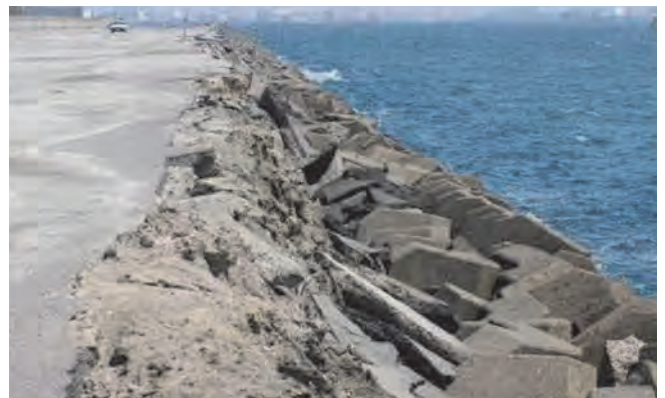
写真2.4 河川・海岸護岸の被害状況(左:境川の護岸、右:日の出護岸)
