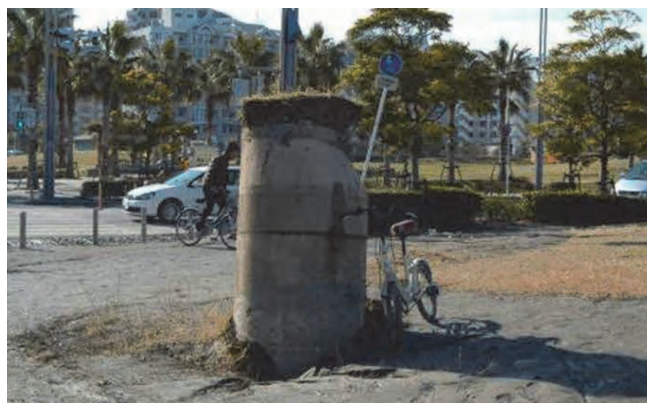
写真1.1 浦安市内の液状化被害の状況(路面の液状化、建物の傾斜、マンホールの突出)
