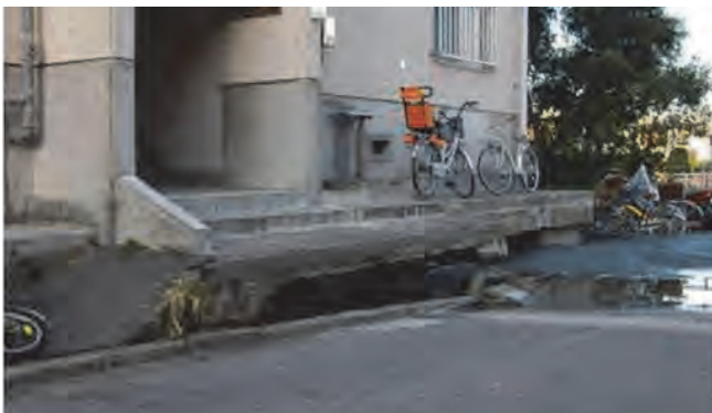
写真2.2 大、中規模建物の被害状況(周辺地盤の沈下)
