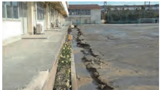
写真2.2 大、中規模建物の被害状況(周辺地盤の沈下)
