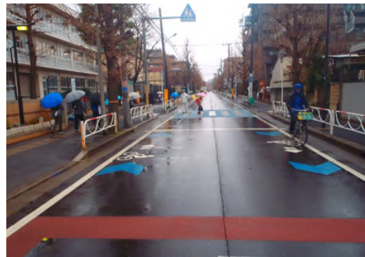
写真 自転車走行指導帯整備例
