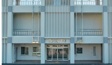
運動公園野球場（スタンド棟）
