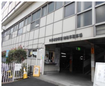
新浦安駅第1自転車駐車場
