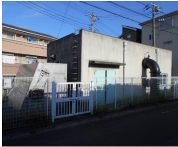
五丁歩排水機場
