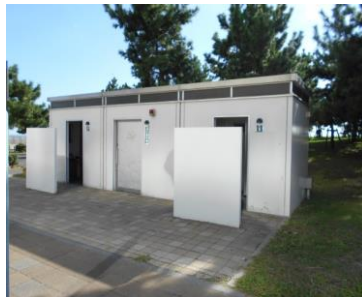
総合公園緑道側トイレ
