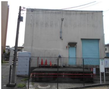
猫実4丁目排水機場
