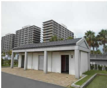
総合公園駐車場側トイレ
