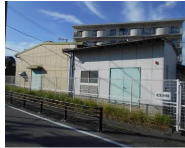
船刈川第2排水機場
