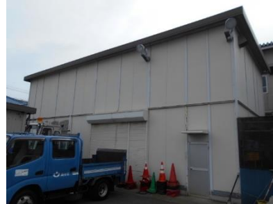
北栄水防倉庫
