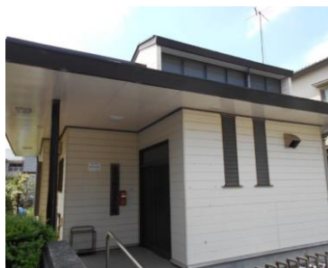
堀江長寿クラブ会館
