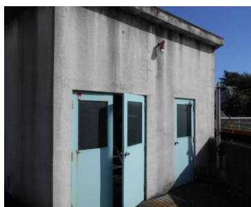
山城屋前排水機場
