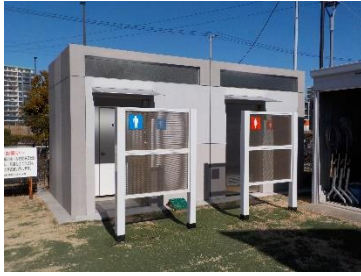
高洲海浜公園パークゴルフ場 (トイレ)
