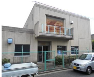
舞浜ポンプ場
