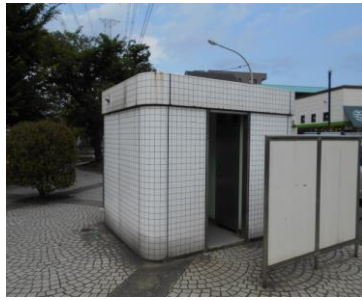
しおかぜ緑道トイレ (堀江1丁目)
