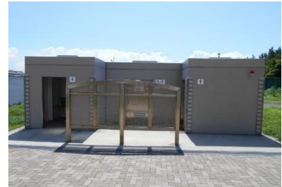
高洲地区西側緑地（中央区域） トイレ
