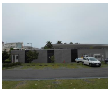
総合公園防災備蓄倉庫
