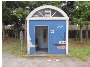
堀江ドックなかよし公園トイレ
