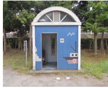
堀江ドックなかよし公園トイレ
