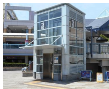
新浦安駅前広場エレベーター棟
