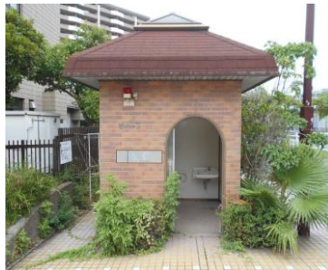
高洲地区境川沿い緑地トイレ
