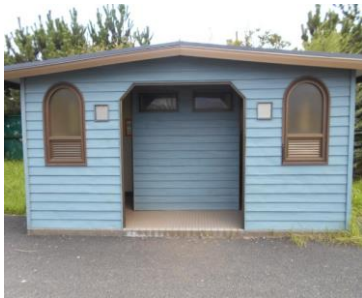
高洲海浜公園トイレB
