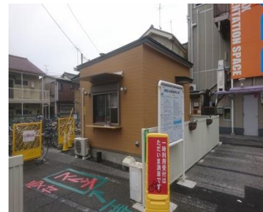
浦安駅第4自転車駐車場 (管理棟)
