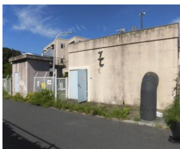
小川丸排水機場
