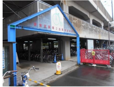
新浦安駅第2自転車駐車場 (増築棟)
