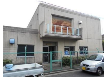
舞浜ポンプ場
