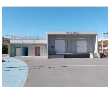
浦安公園防災倉庫・ 災害時対応屋外トイレ
