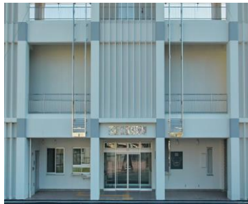
運動公園野球場 (スタンド棟)
