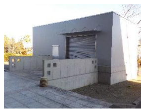
運動公園総合体育館 (屋外倉庫)
