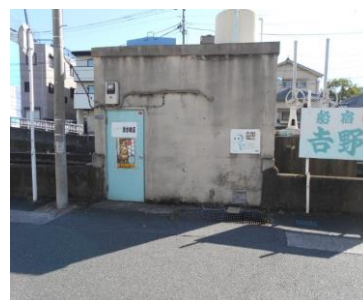
本沢前排水機場
