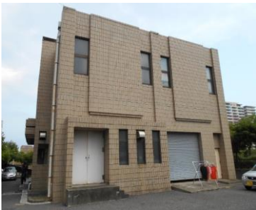
高洲ポンプ場
