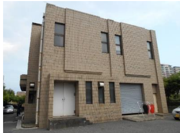
高洲ポンプ場
