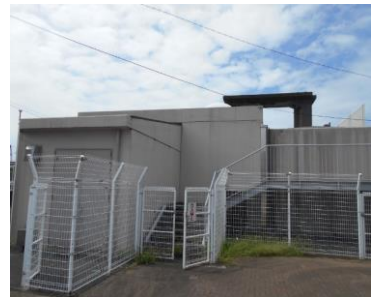
船刈川第2排水機場
