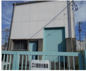
江川橋排水機場
