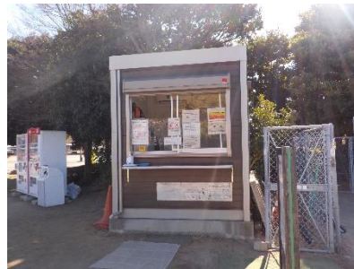
運動公園スケートボード場（管理棟）
