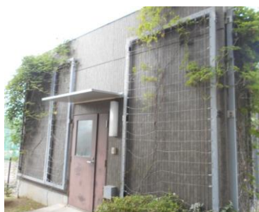
海楽公園内防災備蓄倉庫・ 用具倉庫
