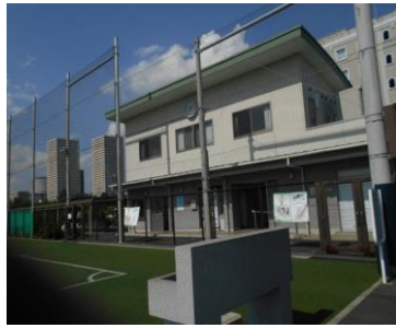
明海球技場 (管理棟)
