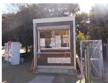
運動公園スケートボード場 （管理棟）
