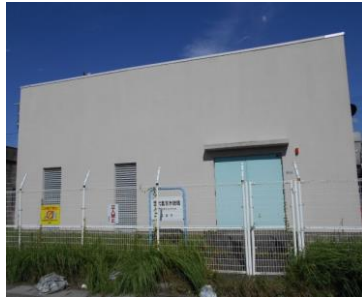
当代島排水機場
