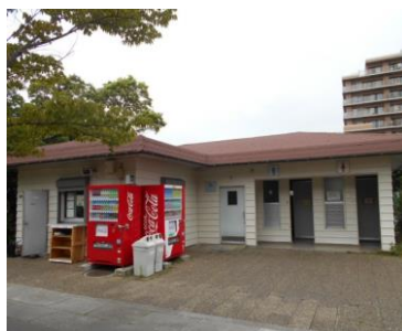
高洲中央公園管理事務所 及びトイレ
