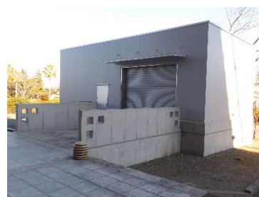
運動公園総合体育館 （屋外倉庫）
