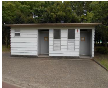
高洲中央公園トイレ
