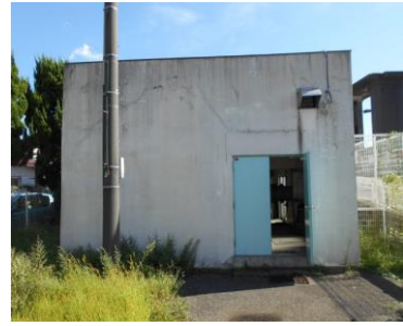
船刈川排水機場
