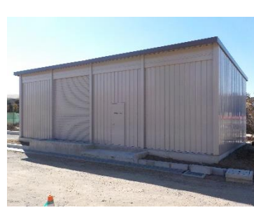
舞浜公園防災倉庫
