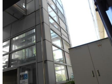
新浦安駅北側エレベーター棟
