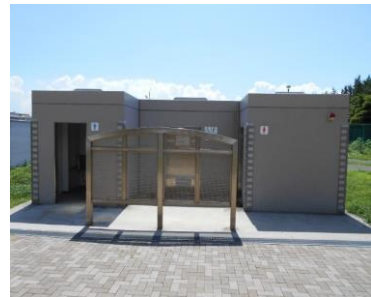
高洲地区西側緑地 (中央区域) トイレ
