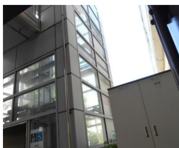
新浦安駅北側エレベーター棟
