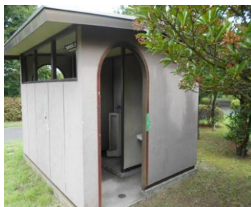
高洲太陽の丘公園トイレ B
