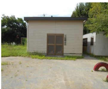
富岡小学校防災備蓄倉庫
