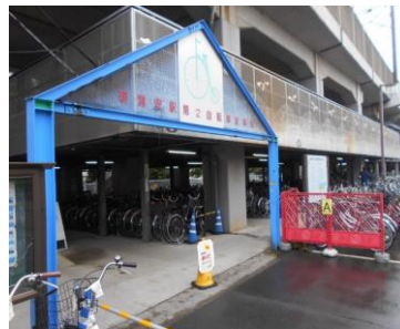
新浦安駅第2自転車駐車場 (増築棟)
