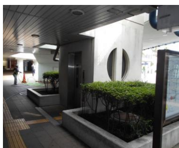
舞浜駅エレベーター棟
