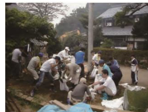
家屋周辺の泥だしをしている様子(福井県) 写真提供: 蓮本浩介
