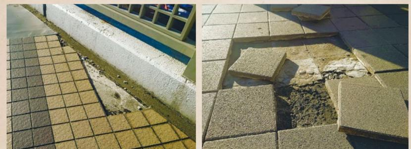
舞浜駅南口歩道橋は、駅の開業と同時に整備・供用開始され、34年が経過しています。これまでもデッキ上の部分補修を行ってききましたが、タイルの破損や凹凸が多く見られています。
