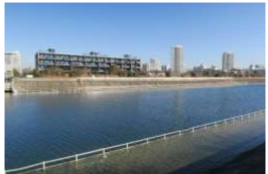
図9 新町地域の水辺テラス水没箇所
