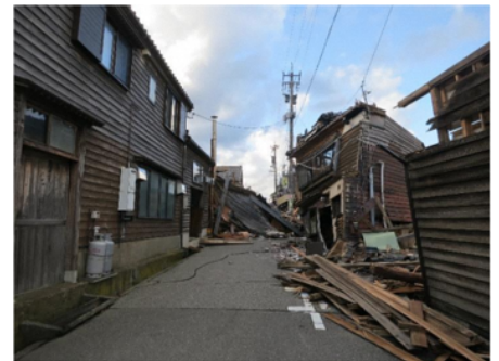
焼失した区域周辺の様子
