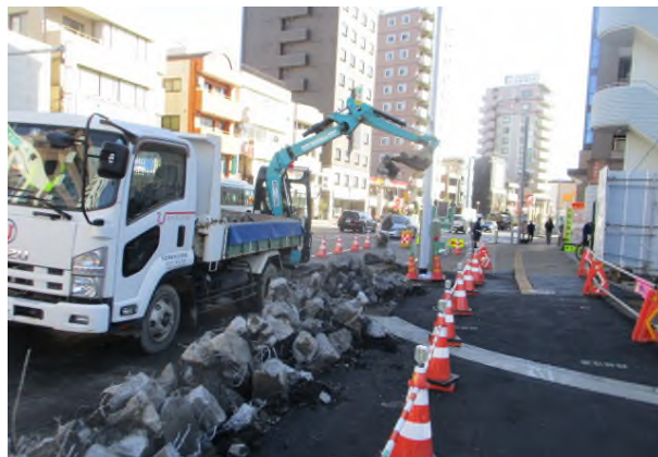
側溝の撤去（やなぎ通り）
