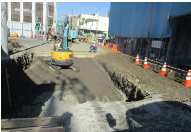
道路築造（浦安小学校側より）
