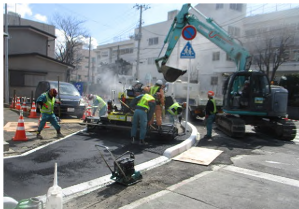
歩道の整備（浦安小学校付近）
