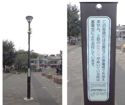
写真6-1-5 蓄電池式照明施設
